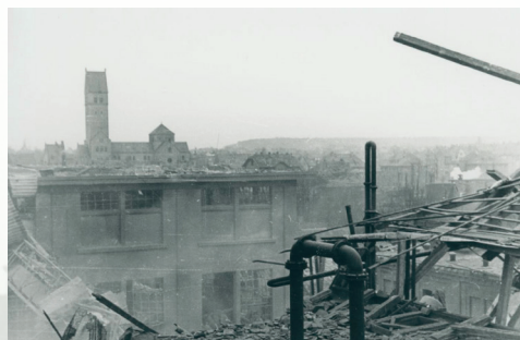
Bombenschäden Maggi-Fabrik (Stadtarchiv Singen)
